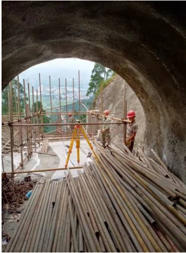
照片 3-10 隧道加固工程施工
