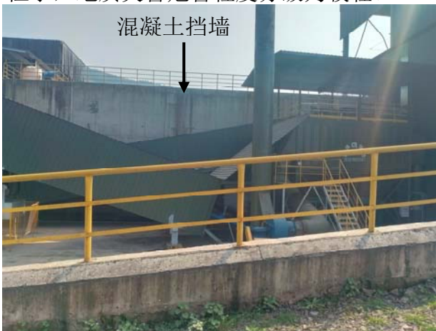
照片 3-1 破碎站支护挡墙
