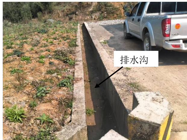
照片 3-3 破碎站排水沟
