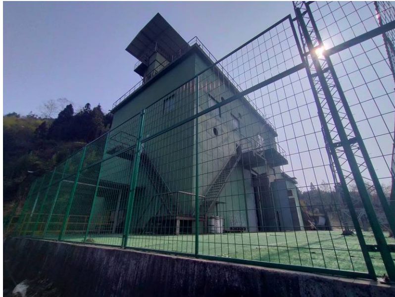
照片 3-12 转运车间
