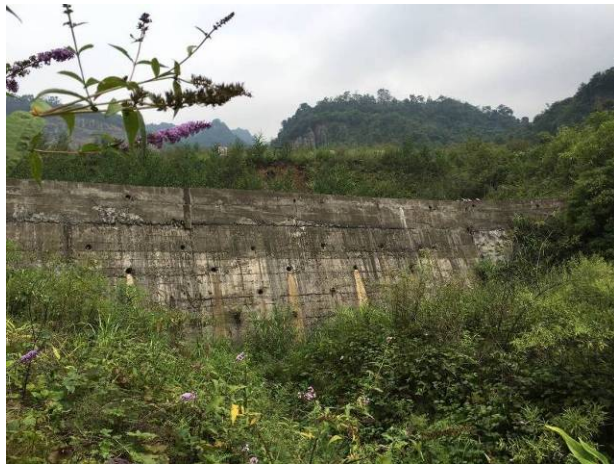
照片 2-6 原排土场下方钢筋混凝土拦挡坝
