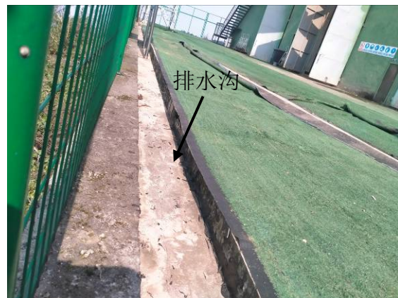
照片 3-6 破碎站排水沟
