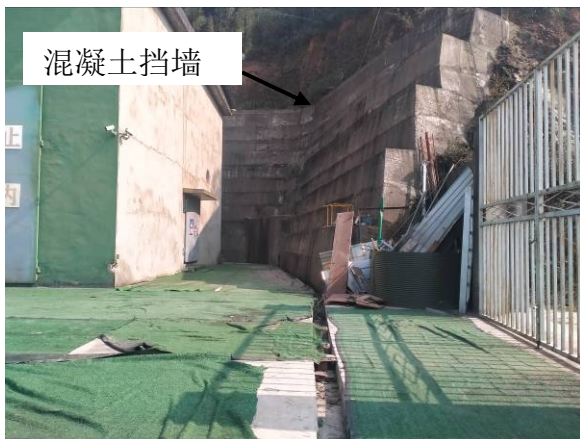
照片 3-5 破碎站支护挡墙
