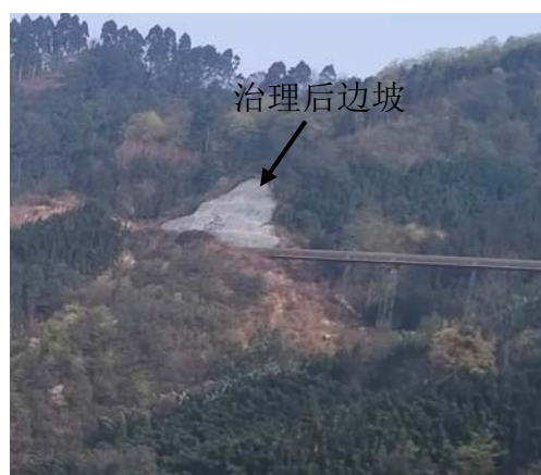
照片 3-9 边坡治理后现状
