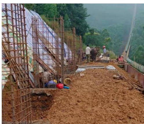
照片 3-8 边坡治理施工
