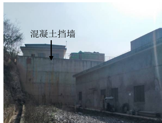
照片 3-2 破碎站支护挡墙
