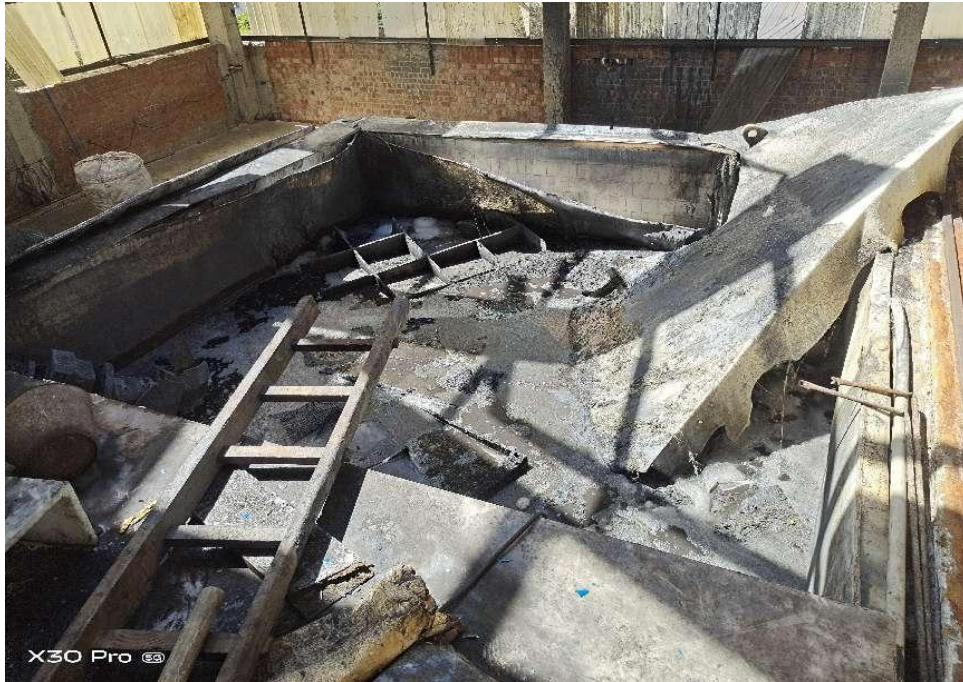
(图3事故现场燃爆1#池)
